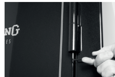
Bild 5. Justering av gångjärn
